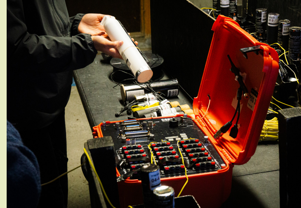
AVFYRINGSSYSTEM: Alle effektene kobles med ledninger til en modul som antenner dem i riktig rekkefølge og til rett tid.
